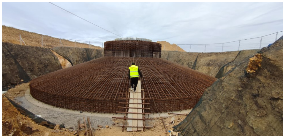
Slika 1. Izgled armaturnog koša jednog od temelja
