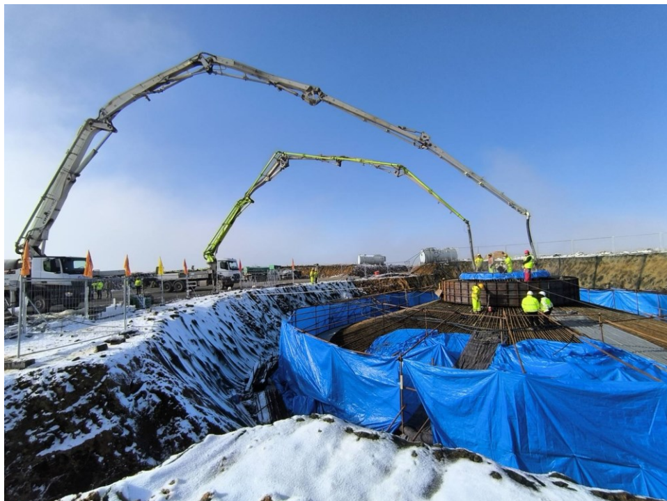
Slika 9. Proces betoniranja temelja
