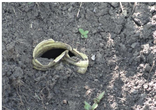
Slika 6. Oštećenja izliva
