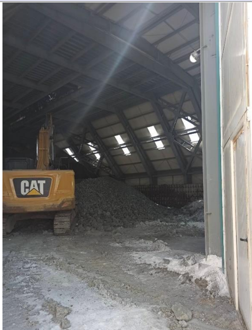
Slika 3. Zatvoreno skladište primarno izdrobljene rude
