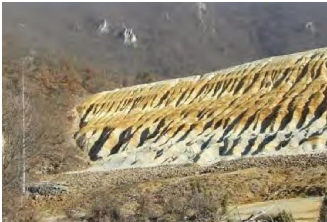
Slika 1. Napušteno jalovište rudnika Šuplja Stijena u Gradcu
