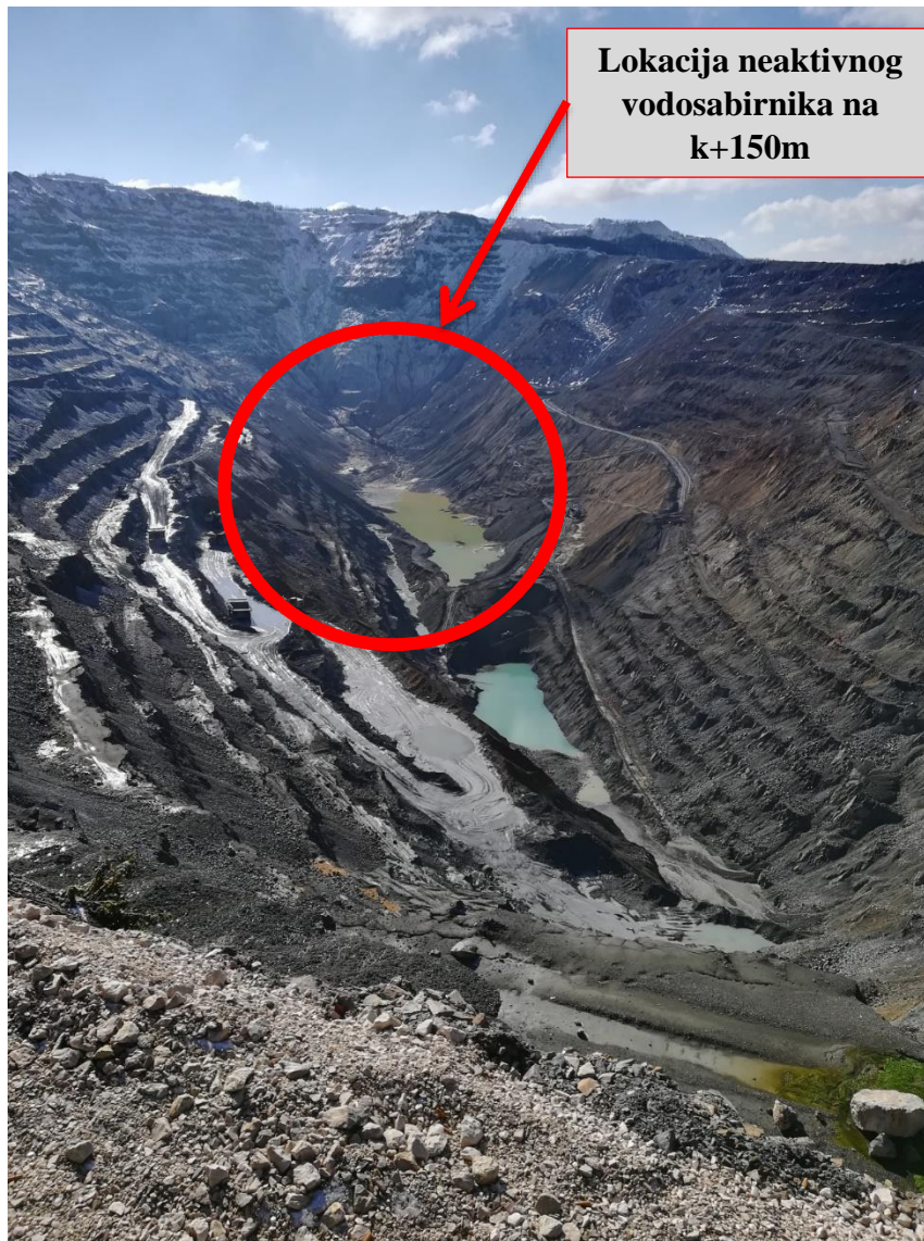
Slika 1.1. Površinski kop Južni revir sa prikazom neaktivnog vodosabirnika na k+150m i aktivnog vodosabirnika na k+125m (pogled sa severne strane)
