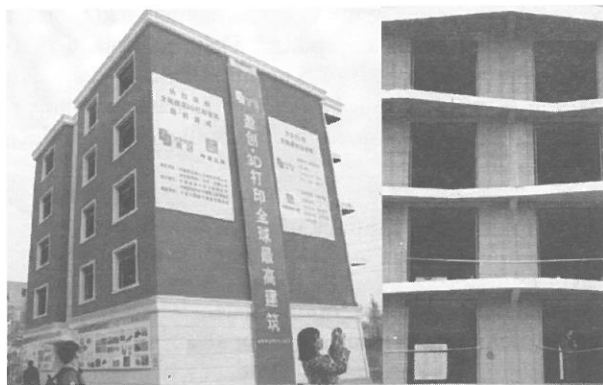
Slika 10.- Pogled na četvorospratnicu izrađenu modularnom tehnologijom
