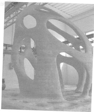
Slika 5.- Radiolaria - Prva primena stereolitografije u građevinarstvu
