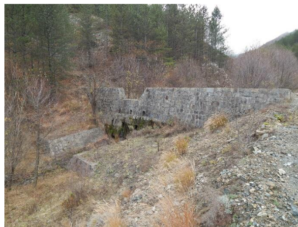
Slika 4. Pregrada od KCM u bujičnom toku Kačaruša
