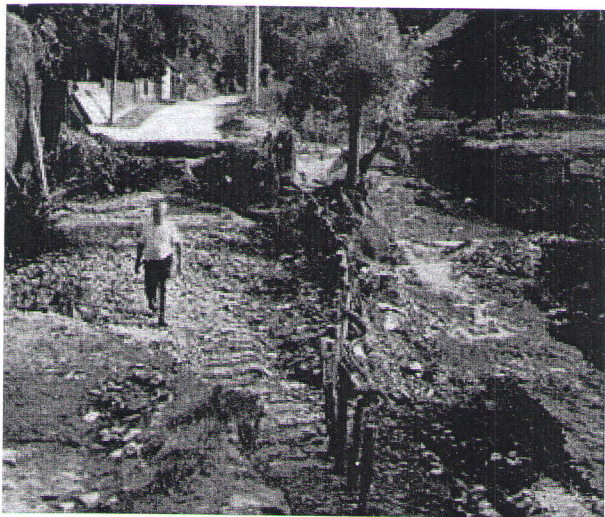
Слика 9. Оштећена путна инфраструктура дуж Јасенице Figure 9. Destroyed Infrastructure by the river Jasenica
