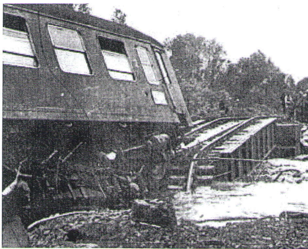
Слика 2. Рушење моста на Корбевачкој реци Figure 2. Bridge collapse on the Korbevačka River
