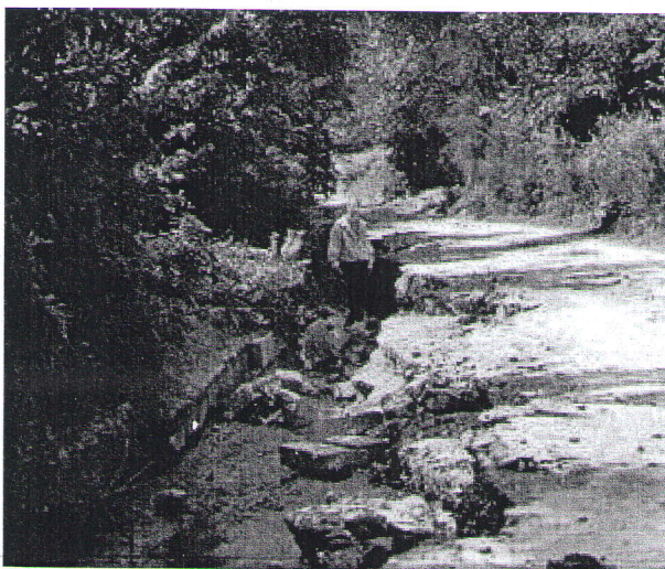
Слика 10. Регионални пут V. Градиште – Рам пресечен бујицом Figure 10. Regional road V. Gradište – Ram destroyed by the flash flood
