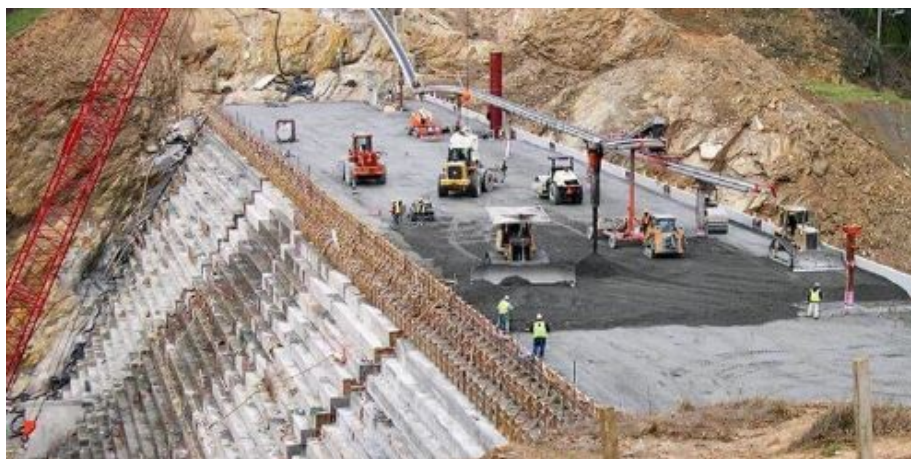
Slika 2. Izgradnja brane od valjanog (RCC) betona [4]
