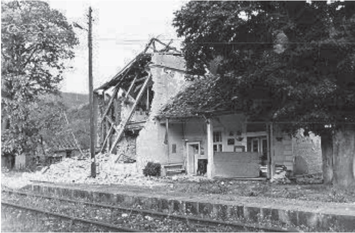
Срушена Железничка станица Богutowачка Бања. 15
