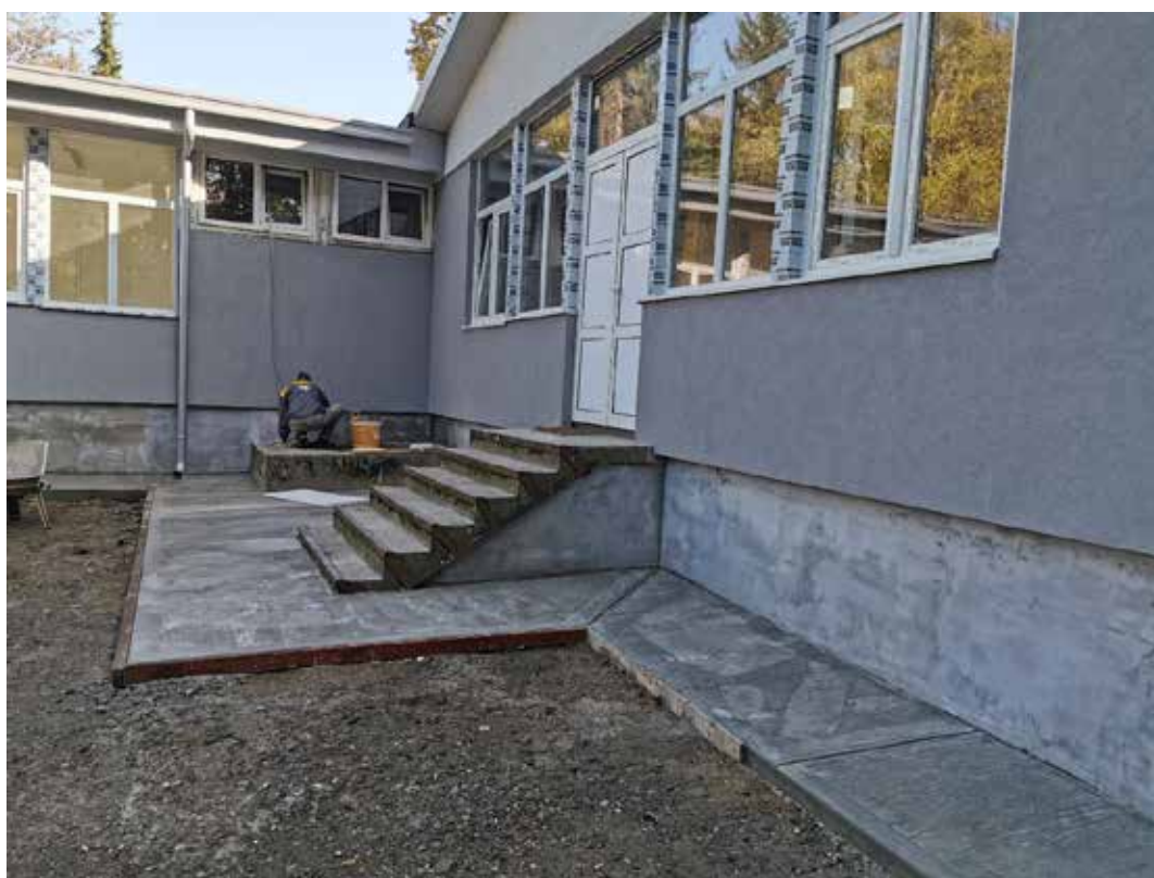
Адаптација фасаде / Facade adaptation, 2020
