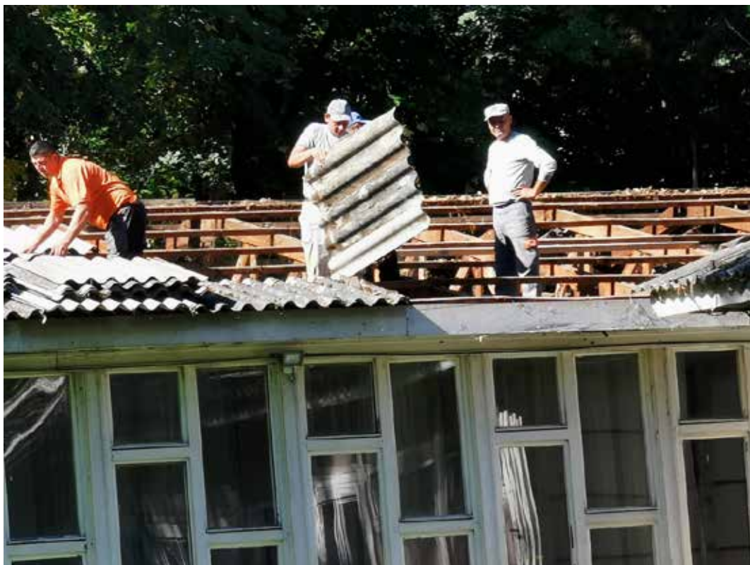
Радови на замени кровног покривача / Works on replacing the roof covering, 2020
